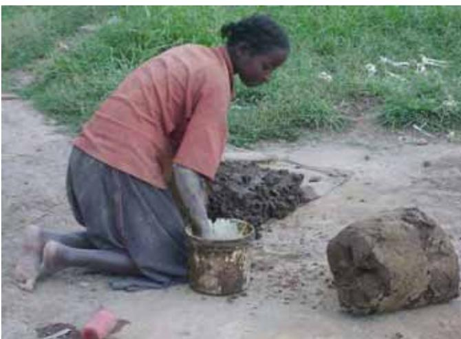
Le due tipologie di terreno vengono mescolate a secco (50% e 50%) ed impastate con l'aggiunta progressiva di acqua. L'operazione è sempre compiuta da un gruppo di almeno tre donne, che si alternano nei lavori necessari: impastare, aggiungere acqua ed aggiungere terra. L'impasto viene poi composto in forma di cilindro (nella foto in basso a destra) e lasciato riposare per alcune ore, in modo che la consistenza diventi uniforme (consistenza molto solida, simile a quella dello stucco da finestre).
