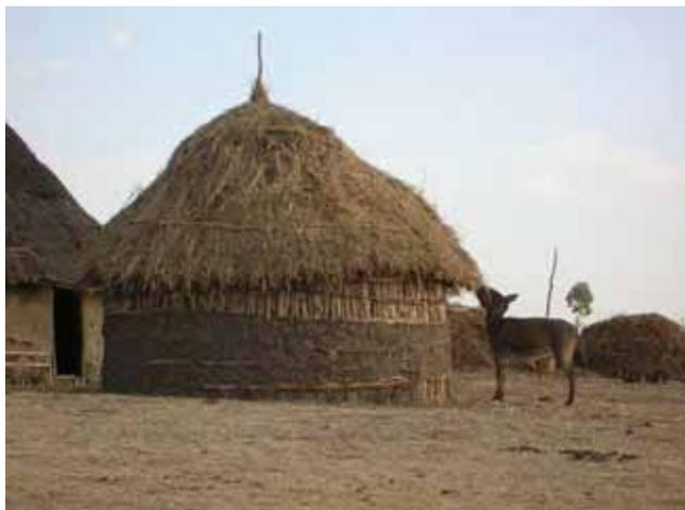
Il goghobet è la tipologia abitativa tradizionale. Si tratta di un impianto circolare imperniato polare, costruito con una palificata di legni tamponati esternamente (e solo di rado anche internamente) di terra. Il tetto è realizzato con una struttura lignea (o in canne palustri) con un manto di paglia.
