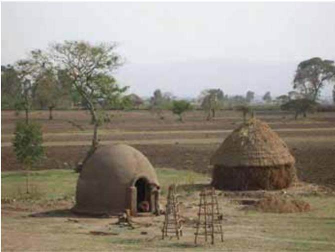
Si tratta di una struttura a cupola autoportante in blocchi di terra stabilizzata.
