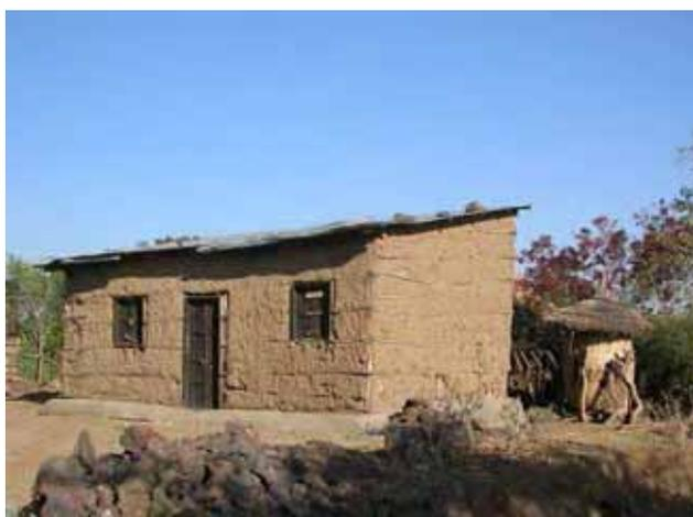
Il korkorobet è un edificio a pianta rettangolare, con muri in struttura lignea e tamponamento in terra, e con il tetto in lamiera ondulata, ad una o due falde. L'interno è diviso generalmente in due vani con una logica funzionale simile a quella del goghobet.
